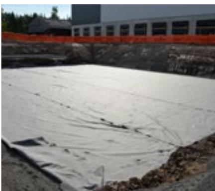
L'ensemble de la SAUL doit être enveloppé d'un géotextile approprié, p. ex. RigoFlor. Avant la pose des blocs, le géotextile doit être étendu sur toute la surface plane. Le géotextile doit déborder suffisamment sur les côtés afin de pouvoir ensuite envelopper l'ensemble de l'ouvrage.
