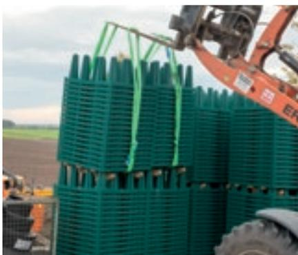
En raison de la hauteur d'empilage de 2,55 m, il est recommandé de séparer les deux palettes empilées pour faciliter le soulèvement et le traitement des éléments de base. Nous recommandons pour cela l'utilisation de sangles de levage.
