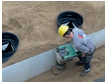
30 cm maximum à l'aide d'un appareil de compactage léger ou mi-lourd (compacteur de surface ou dame vibrante). Atteindre alors un taux de compression  $D_{pr} \geq 97\%$ . Veiller à ne pas endommager les blocs durant ces opérations. Les directives nationales relatives aux travaux de terrassement (comme p. ex. ZTV E-StB) sont à respecter. S'assurer que les opérations de remblaiement et de compactage ne
