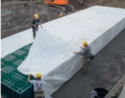
Un ouvrage Rifogill destiné à l'infiltration doit être entièrement recouvert d'un géotextile (p. ex. RigoFlor). Prévoir un chevauchement suffisant (au moins 50 cm) des bords afin qu'aucun matériau de remblaiement ne retombe dans l'ouvrage. Créer une ouverture pour les tubes en découpant le géotextile en croix afin d'éviter au sable de pénétrer.
