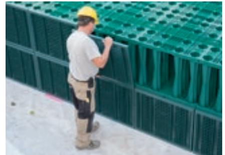
En fonction des exigences du chantier, les grilles de parois latérales peuvent être mises en place à l'extérieur de la fouille.
