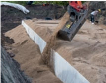
Les raccords de blocs maintiennent en place les différents blocs Rigofill ST-A et empêchent que l'ouvrage ne glisse latéralement au moment du remblaiement. Pour le remblaiement, utiliser un matériau de terrassement non cohésif et non gelé, de granulométrie inférieure à 32 mm. Les matériaux de remblaiement doivent être introduits de toutes parts et de manière homogène puis compactés en couches de
