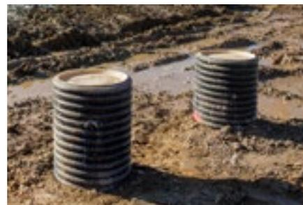
Couvercle de chantier des rehausses
