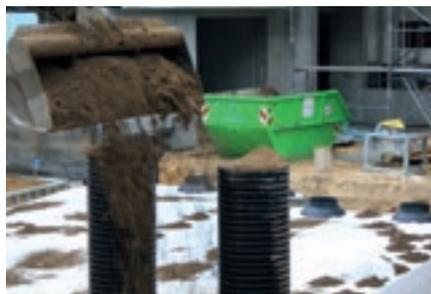
Fonction du couvercle de chantier lors du remblaiement
