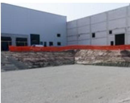
Avant d'installer les blocs Rigofill ST-A, les fondations de l'ouvrage doivent être horizontales, planes et bien stables. Poser sur le fond de la fouille une couche de réglage d'environ 10 cm, de préférence en gravillons (p. ex. 2/5 mm grains fins), graviers drainants ou sable. Cette couche doit être compactée et former une structure plane.
