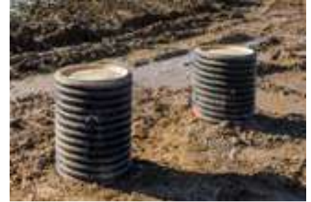
Afdekking voor de bouwfase van de opzetbuizen
