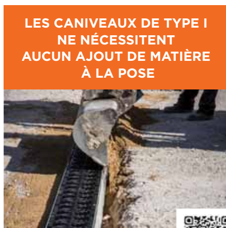
Mise en oeuvre d'un caniveau de Type I
