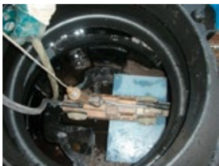
Controle van de reiniging d.m.v. een rioolinspectiecamera. De camera staat op de onderhoudsconsole van een SediPipe L-installatie
