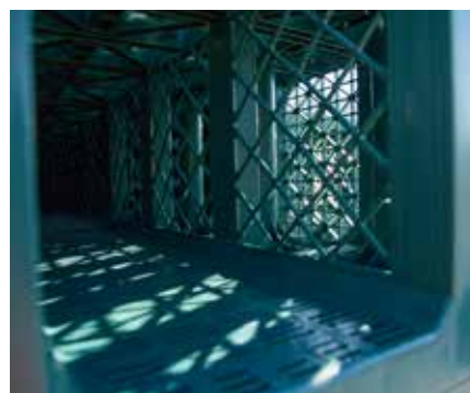
Grandes ouvertures de la paroi latérale du tunnel
