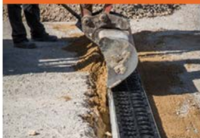
Plaatsing van een I-type roostergoot
