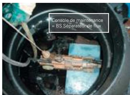
Contrôle du rinçage avec la caméra à tête rotative pivotante, la caméra sur console de maintenance dans le regard de départ d'une installation SediPipe basic
