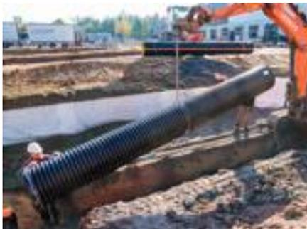
2. Placer le tube de sédimentation en position de montage
