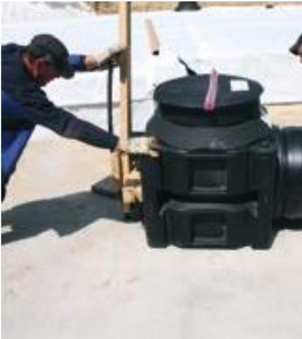
Le second regard doit être posé à hauteur voulue sur la plateforme préparée. Préparer ensuite le raccord du manchon et enfoncer le regard sur le tube de sédimentation. Connecter la conduite d'arrivée ou d'évacuation selon les spécifications de planification (cf. point 4.4).
