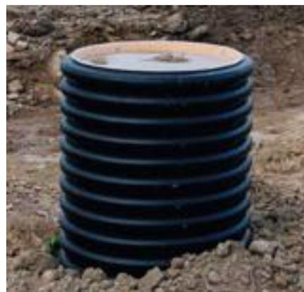
Couvercle de chantier des rehausses
