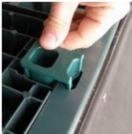
Fixatie met getrapte adapterklem
