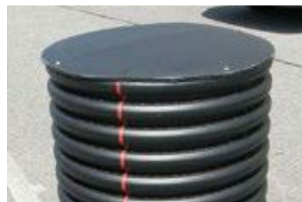
Afdekking voor de bouwfase van de opzetbuizen
