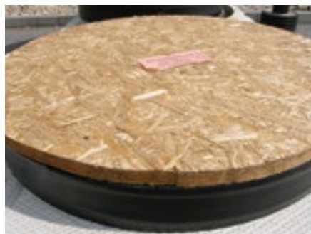
Beschermende afdekking bij put met betonnen afdekplaat
