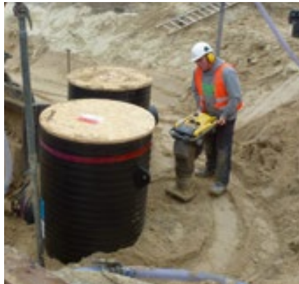
Afdekking voor de bouwfase
