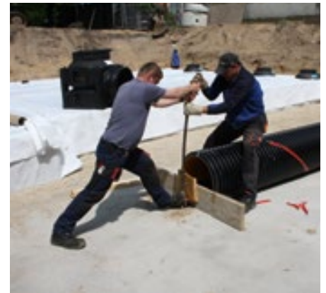
Montage sedimentatiebuis
