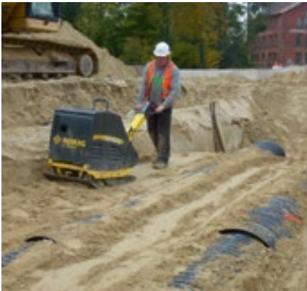
Verdichten van de zijdelingse opvulling
