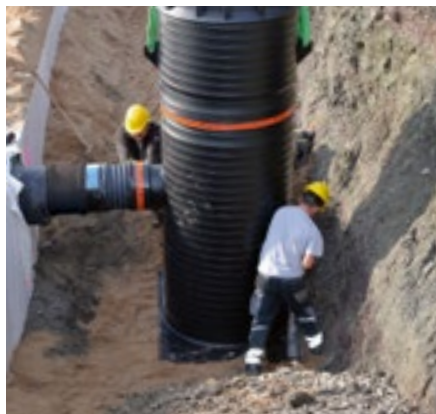
Voorbeeld: eindput in combinatie met Rigofill-infiltratiesysteem
